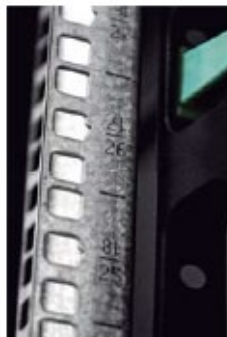
Unidades rack numeradas en todos los perfiles
