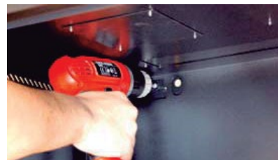
Detalle de fijación interior después de colgar el mural en la pletina
